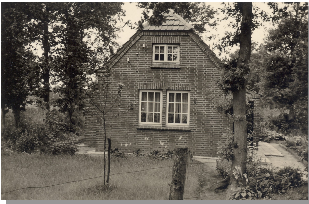
Das Haus vor dem Umbau
